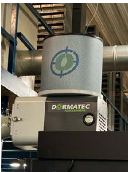
Dormac CNC Solutions heeft het project in Groenlo turnkey opgeleverd, tot en met de oliemistafzuiging.
